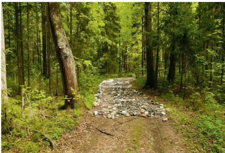
Рис. 3.2.6. Дорога, отсыпанная строительным и бытовым мусором
